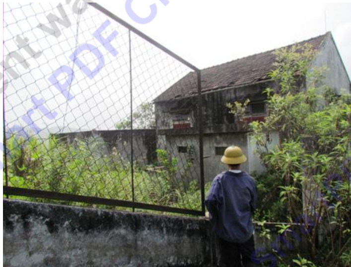
Công trình cấp nước sinh hoạt xã Tân Lộc xây xong rồi bỏ hoang.
