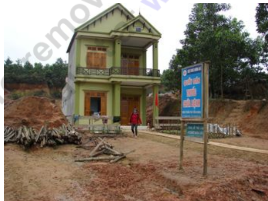
Nhà bà Trần Thị Khoa được đơn vị quân đội giúp xây dựng.
